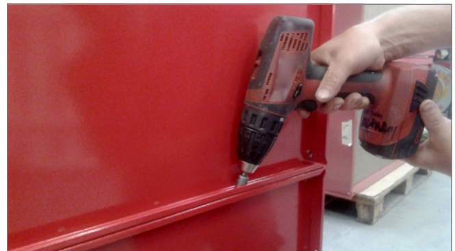
Bild 6: Flansche der Seitenwände aufeinanderschrauben
